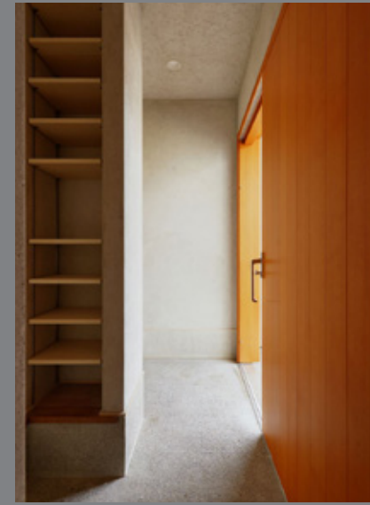
3. E型 1本引・ガラスなし(扉内動) 樹種：米松ピーラー サイズ：FW2200×FH2200 塗装：Livos タヤシリーズ/シーダー
