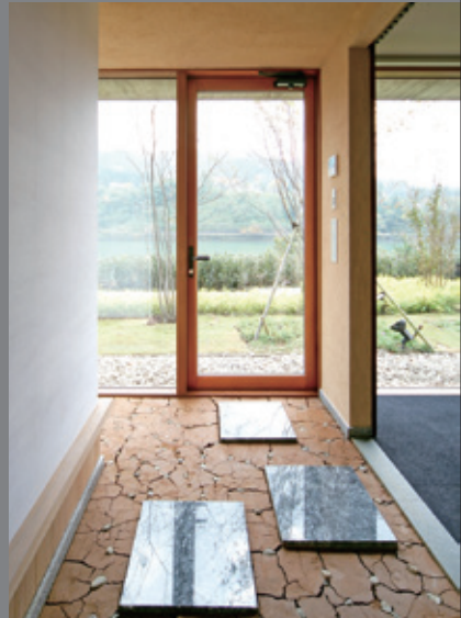
5. 框片開きドア 樹種：米松ピーラー サイズ：FW1012×FH2272 塗装：Livos カルデットシリーズ／ウォルナット
