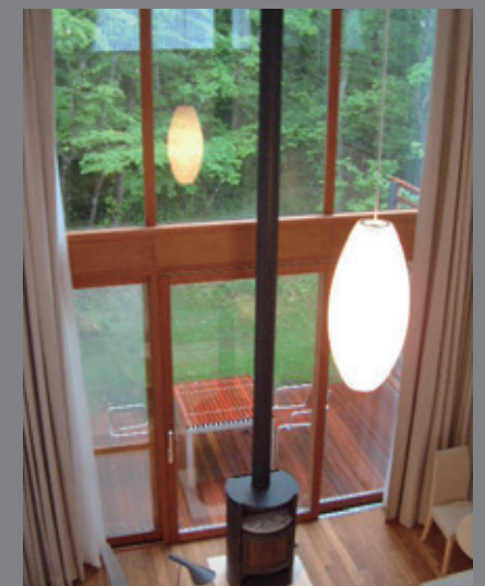
9. HS/片引き窓+はめ殺し窓 樹種：米松ビラー サイズ：FW4512×FH2753 塗装：Livos カルデットシリーズ/ウォルナット *二期倶楽部
