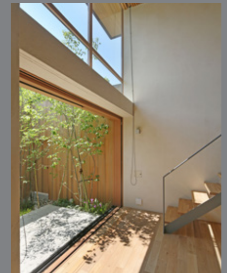
8. HS/2枚引込み窓+はめ殺し窓 樹種：米松ビラー サイズ：FW3170×FH1555+FW3065×FH2570 塗装：Livos タヤシリーズ/チェストナット
