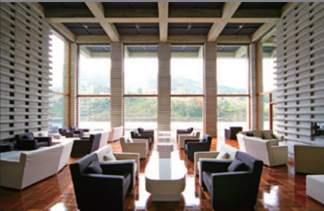
1. はめ殺し窓 樹種：米松ビラー サイズ：FW3000×FH6300 5台 塗装：Livos カルデットシリーズ/ウォルナット *リバーリゾート雅楽倶
