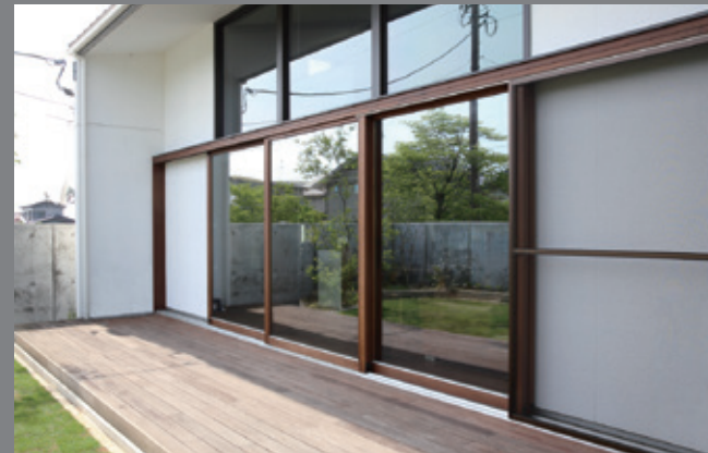
2. 3枚引込み窓 樹種：米松ビラー サイズ：FW9237×FH2625 塗装：Livos タヤシリーズ/ウォルナット+ローズウッド
