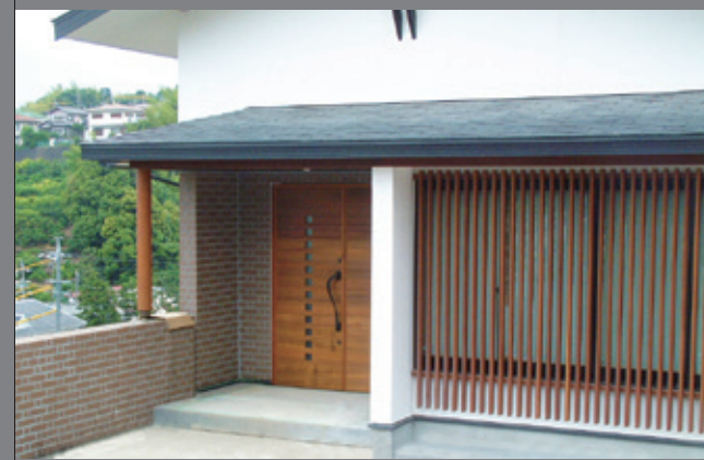
8. 親子ドア 樹種：チーク サイズ：FW1328×FH2312 塗装：Livos カルデットシリーズ／クリアー 〈防火仕様可〉
